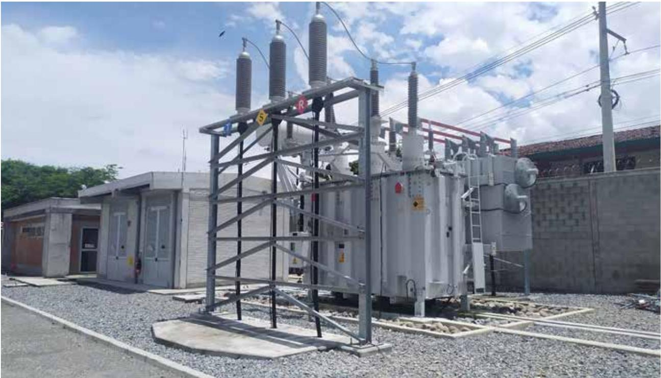
**Figura 14.** Implementación de conexiones en transformador 110/44 kV, 40 MVA, San Jerónimo.
