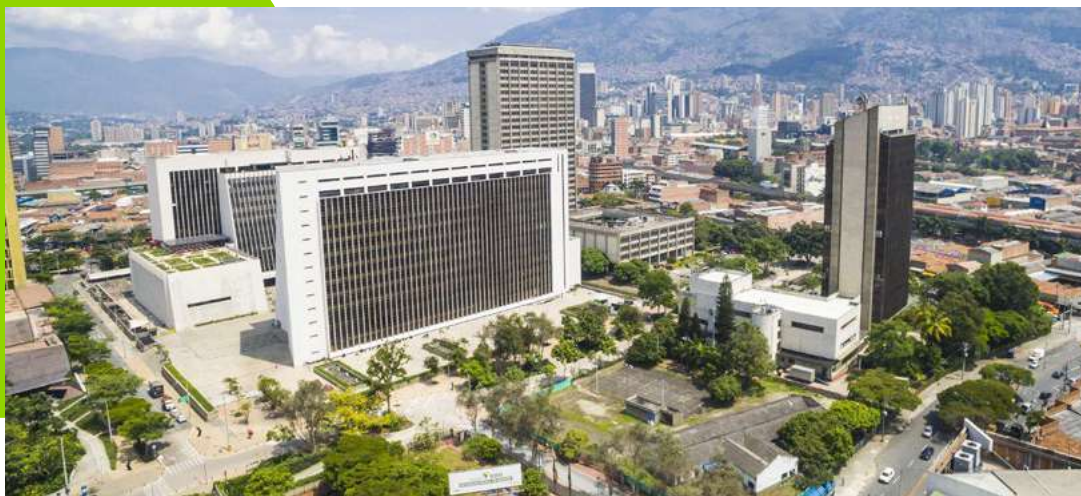
Centro Administrativo La Alpujarra
