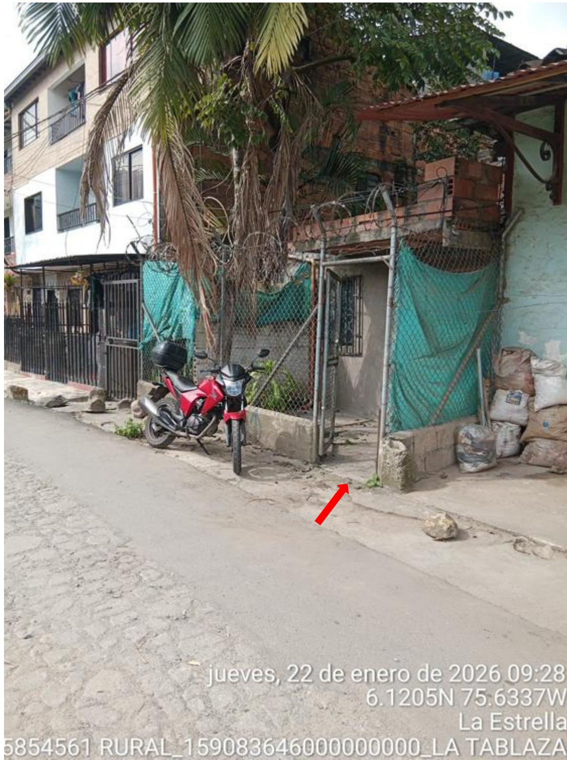
Foto 3: Hacia la vivienda
