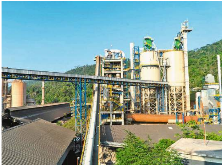
El montaje de la nueva línea de elaboración de cemento verde en Río Claro generó más de 600 empleos. FOTO CEMENTOS ARGOS
