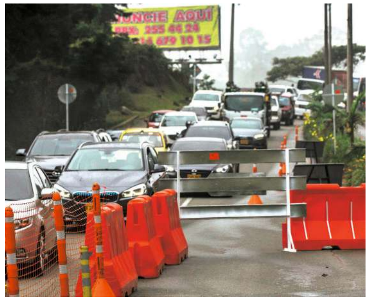
Terminado el Túnel de Oriente, el concesionario seguirá con la operación y mantenimiento de la vía. FOTO EDWIN BUSTAMANTE
