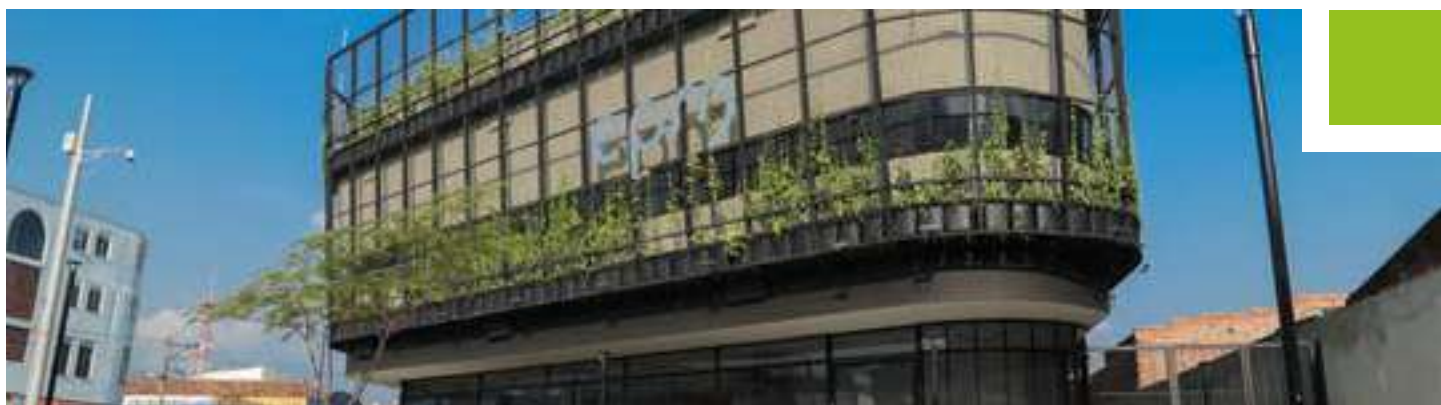
Distrito Término La Alpujarra. Único en Latinoamérica dedicado a la generación de energía térmica para climatización - Medellín
