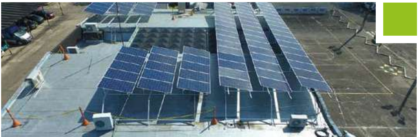
Edificio Parnaso. Sede ESSA, empresa filial del Grupo EPM – Barrancabermeja
