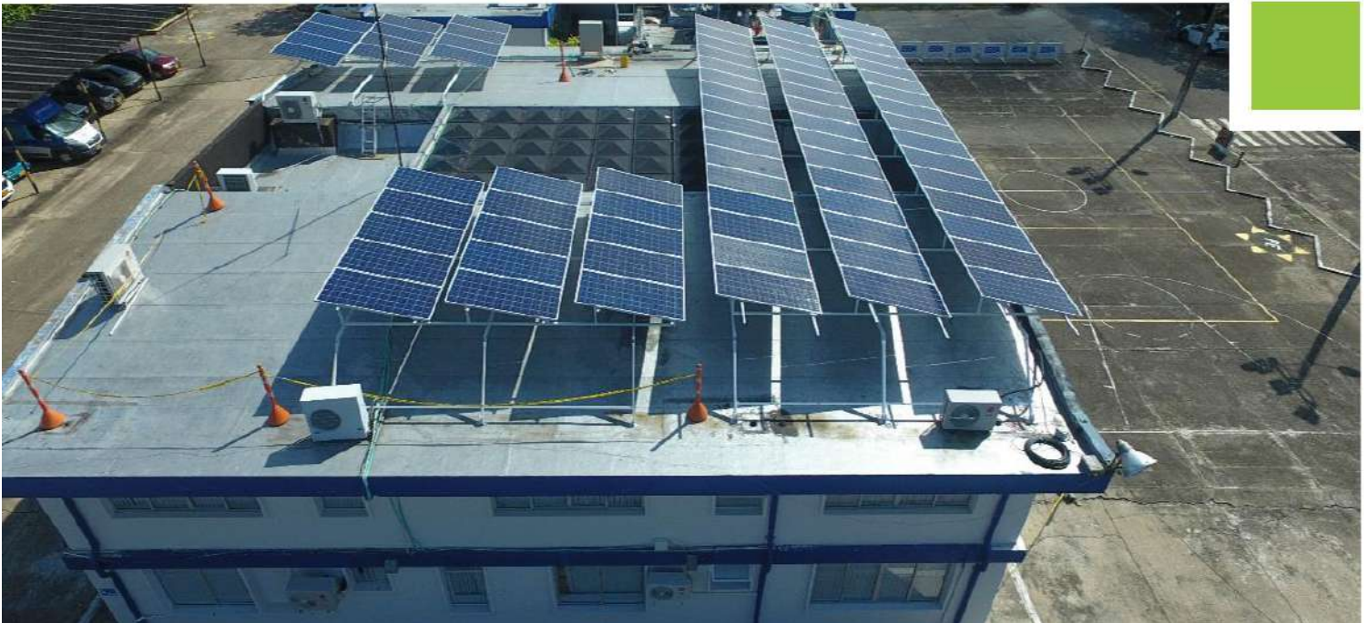
Edificio Parnaso. Sede ESSA, empresa filial del Grupo EPM – Barrancabermeja
