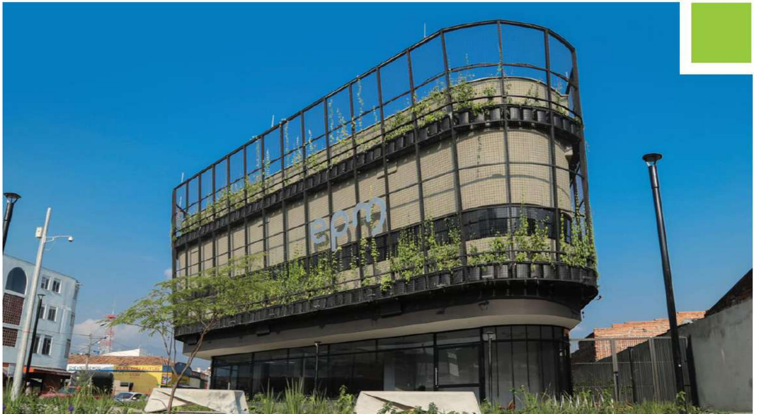
Distrito Término La Alpujarra. Único en Latinoamérica dedicado a la generación de energía térmica para climatización - Medellín
